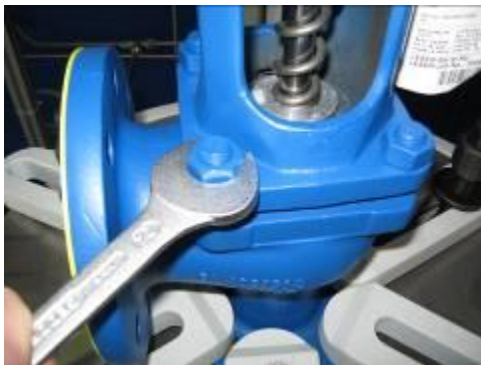
Abb.1 Lösen der Verschraubung
